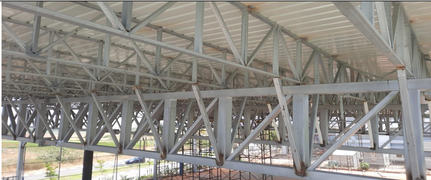
תוספת חיזוק מהנדס אנגל באגד ראשיים – זוויתנים – נמצאו ליקויי ריתוכים, הושלם תיקון ריתוכים בבדיקה סופית 17 יוני
