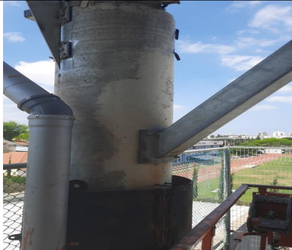
תוספת חיזוק מהנדס אנגל באגד ראשיים – זוויתנים – נמצאו ליקויי ריתוכים, הושלם תיקון ריתוכים בבדיקה סופית 17 יוני
