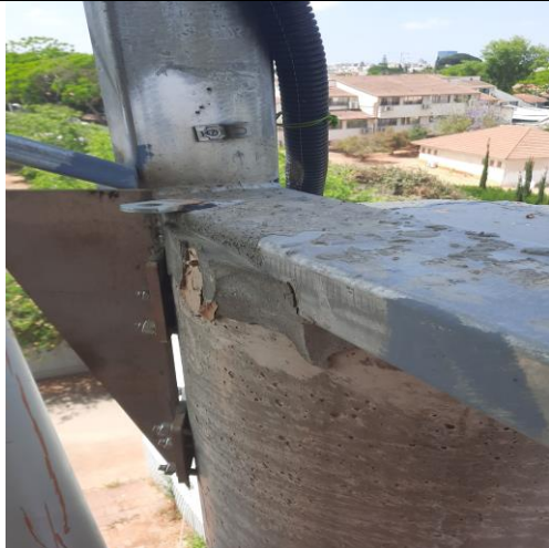
תוספת חיזוק מהנדס אנגל באגד ראשיים – זוויתנים – נמצאו ליקויי ריתוכים, הושלם תיקון ריתוכים בבדיקה סופית 17 יוני
