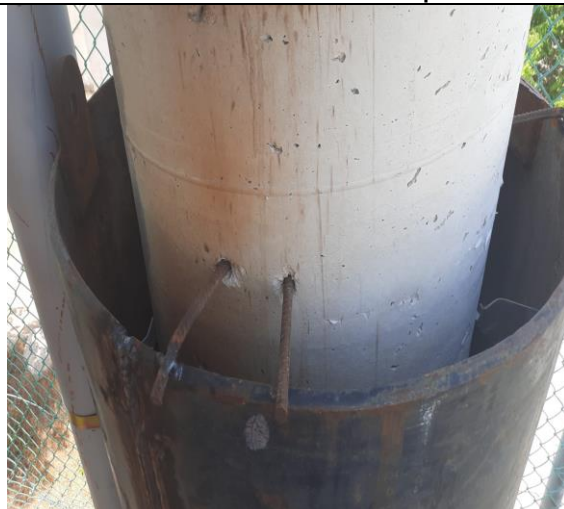
עמוד 1 – חיזוק מהנדס אנגל – זוויתן לאגד ראשי ומשולש למסבח – נמצאו ליקויים בריתוכים- תוקן בבדיקה 17 יוני 2021
